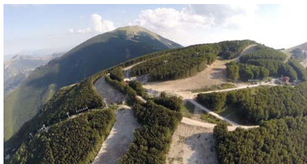
Fig. 8 – Parte della enorme alterazione realizzata per costruire una rete di piste situate sul versante Nord del Monte Acuto (la cima del M. Catria è visibile subito dietro).
