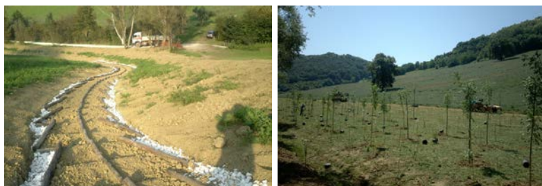
Fig. 13 – A sinistra, lavori di sagomatura del fosso e protezione del terreno con interventi di ingegneria naturalistica; a destra impianto della vegetazione forestale con ricostruzione delle fasce di vegetazione naturale.
